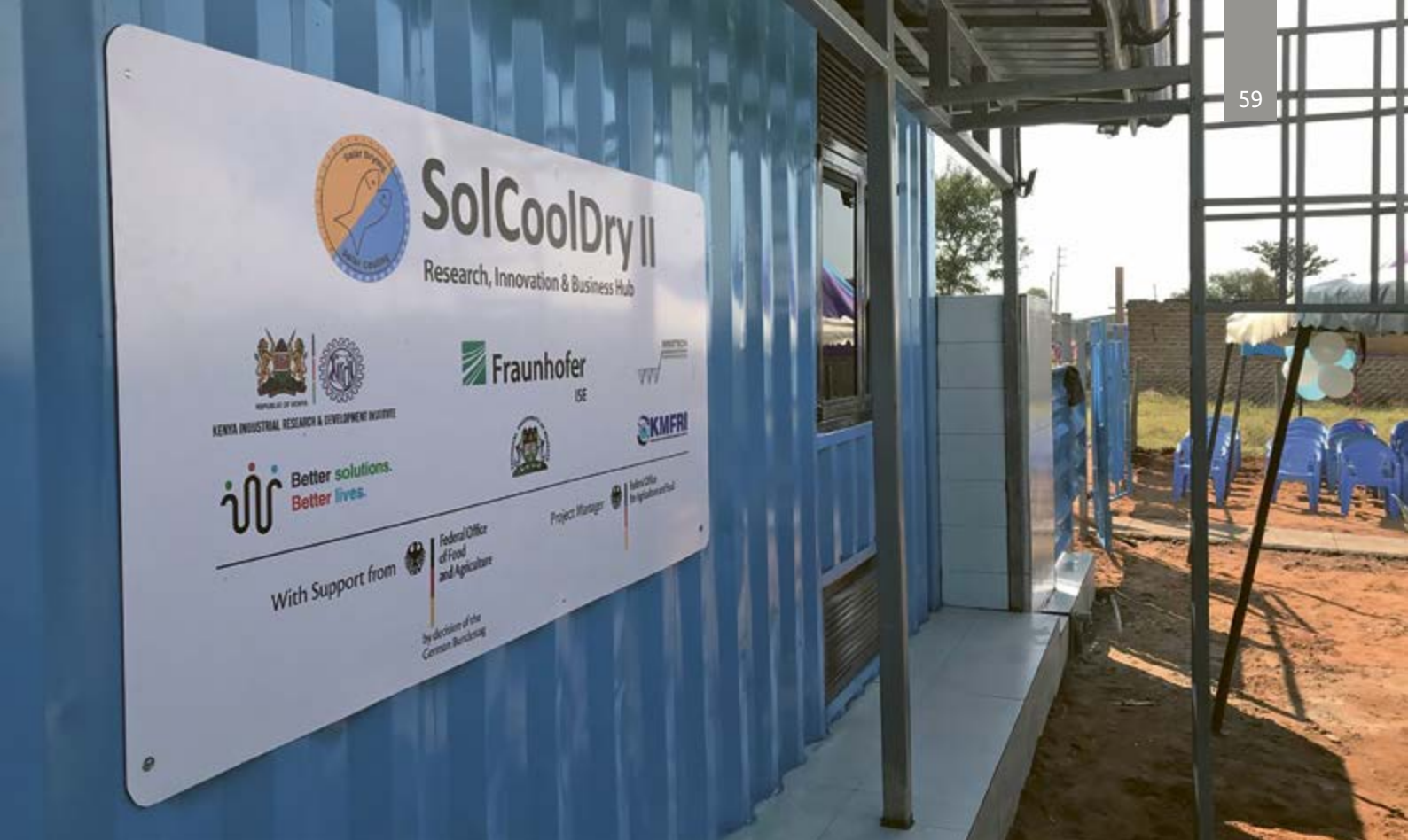
SolCoolDry Anlage, © Matthias Fischer, Innotech Ingenieurgesellschaft mbH
